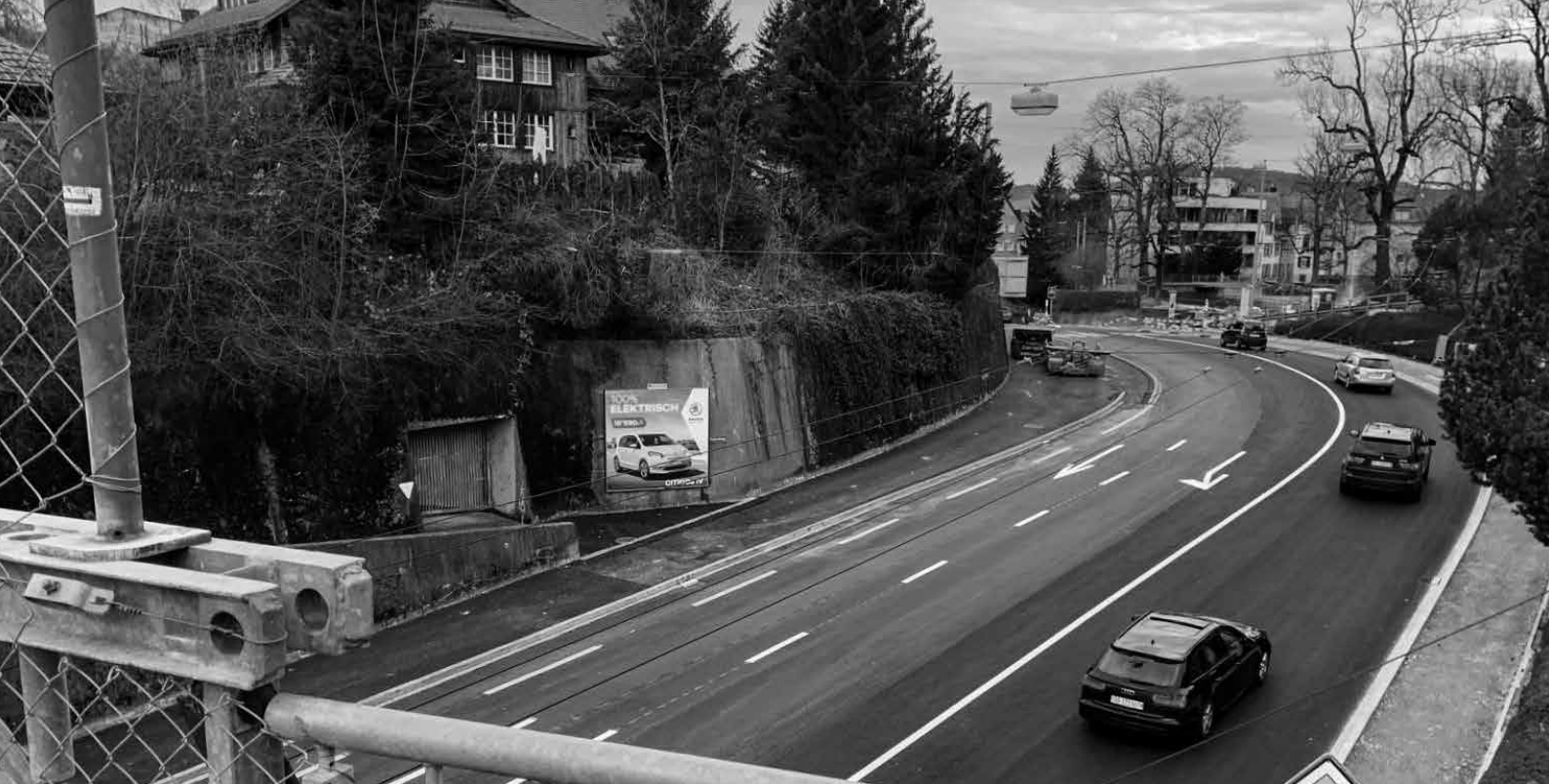
Die Strasse ist jetzt im Rohbau fertig.
